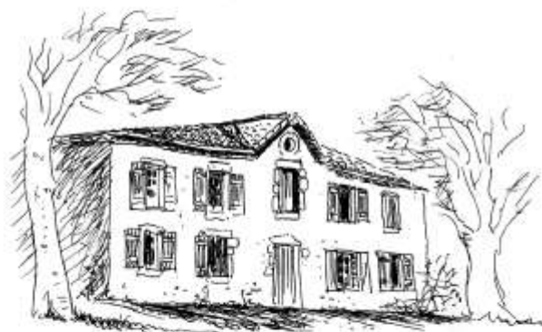
Tursan. Maison carrée ou rectangulaire à 4 pentes, réservée au logis, une gènoise à 3 ou 4 rangs est souvent apparente sur la façade. Les murs sont construits en matériaux durs : briques, pierres et même en galets.
