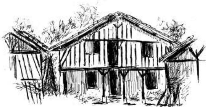
Marsan la maison forme un U avec les autres bâtiments de ferme. Les murs sont à pans de bois et garnis de torchis (paille + argile) de couleur ocre.
