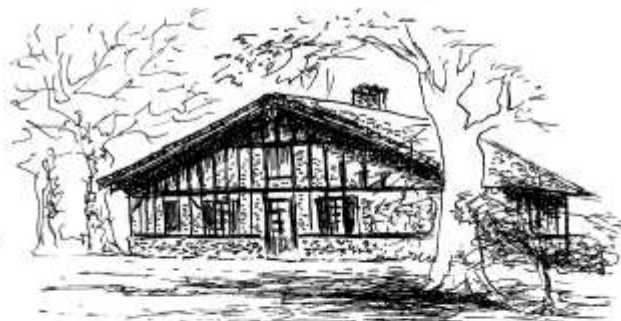
Brassenx Toit à 2 eaux. Le bâti principal est en bois avec des briques posées à plat et non enduites.
